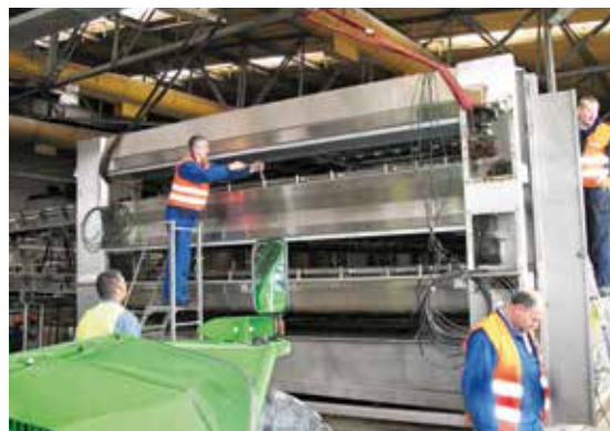
Montaža procesne opreme
